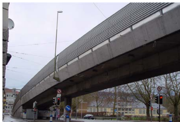
Abb. 20.61 Lärmschutzwand A3 Zürich (absorbierende Wand mit Sinus-Blech-Verkleidung)
