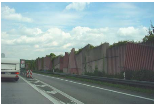
Abb. 20.25 (mutig) Gestaltete Lärmschutzwand, Autobahn, Karlsruhe D
