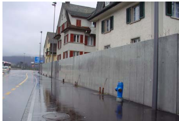
Abb. 20.64 Betonwand, Baden AG
