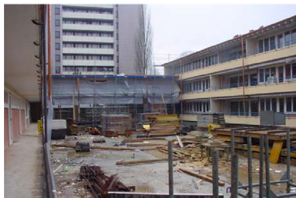
Abb. 20.37 Neuer Zwischenbau, Überbauung Spitalstrasse, Stadt Luzern
