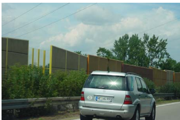
Abb. 20.26 Lärmschutzwand aus Lavabeton mit Glaswischenelementen, Deutschland
