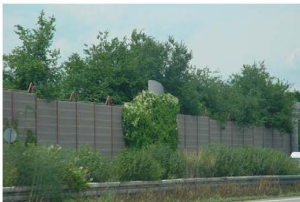
Abb. 20.27 Lärmschutzwand aus Alukassetten, mit gestalteten und bepflanzen Pfeilern, Deutschland
