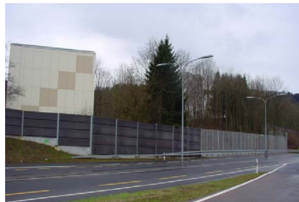
Abb. 20.56 Lavabeton und Glaswand, Sihltalstrasse, Adliswil ZH
