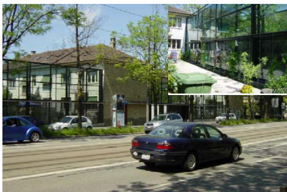
Abb. 20.12 Lärmschutzwand, Ostring, Stadt Bern (Quelle: Stadtplanungsamt Bern)
