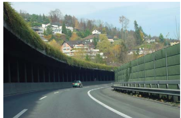
Abb. 20.15 Galeriebauwerk, Nationalstrasse A2, Hergiswil NW
