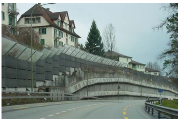
Abb. 20.58 Lavabetonwand mit aufgesetzter Glaswand, Sihltalstrasse, Adliswil ZH
