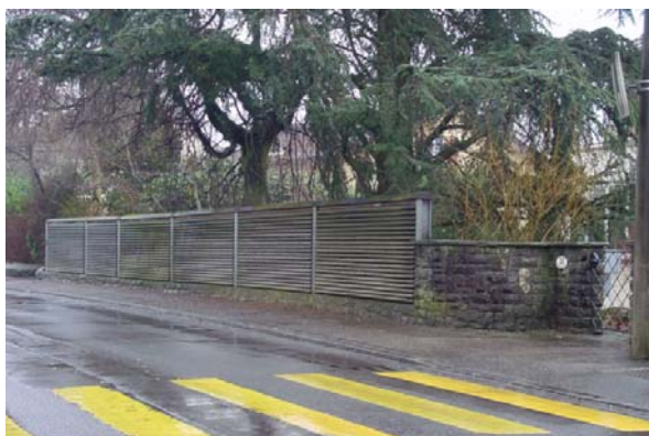
Abb. 20.36 Lärmschutzwand Einfamilienhäuser Hünenbergstrasse, Stadt Luzern
