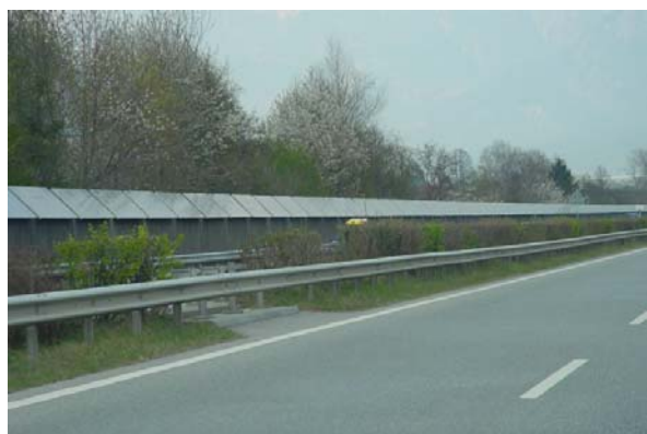
Abb. 20.18 Lärmschutzwand mit Solarzelle, Nationalstrasse A3, Chur / Bonaduz GR
