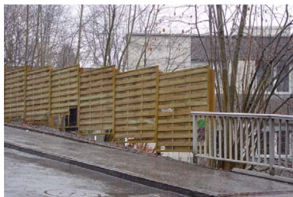
Abb. 20.39 Sicht-, aber kein Lärmschutz, Palisadenwand, Obergütschstrasse, Stadt Luzern
