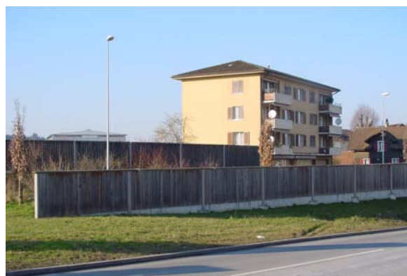
Abb. 20.69 Holz-Lärmschutzwand, SBB-Unterführung, Rothenburg-Station (LU)
