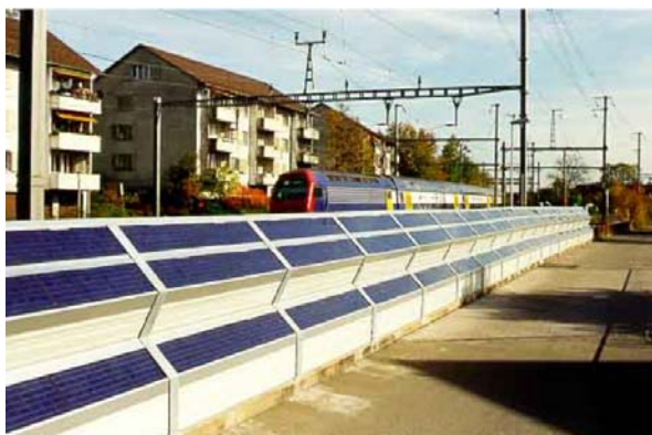
Abb. 20.65 Lärmschutzwand mit Solarzellen, Wallisellen ZH (Quelle: SBB-Publikationen)
