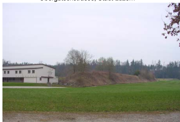
Abb. 20.40 Lärmschutzwand entlang Schussfeld, Schiessanlagen Hüslensmoos, Emmen LU
