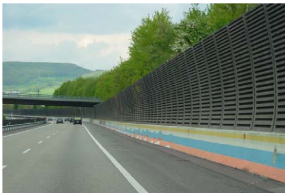
Abb. 20.32 Lava-Betonwand, gekrümmt, A2 Nähe Eptingen BL
