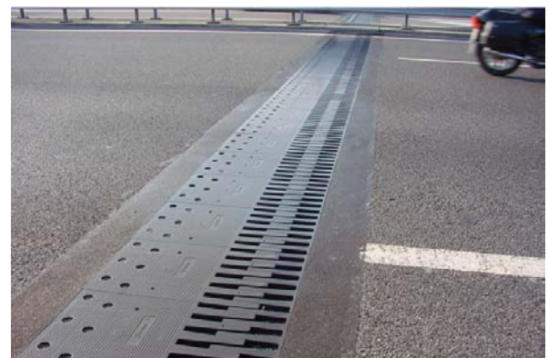
Abb. 20.14 „Finger-„Fahrbahnübergang mit Gummimattenbelegung, Nationalstrasse A1, Lausanne VD
