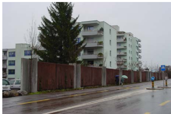
Abb. 20.51 Lavabetonwand (Überbauung Pfäffikon SZ)
