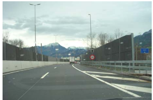
Abb. 20.47 Lärmschutzwände (New Jersey-Elemente / vorgelagerte Leiteinrichtung), A2 Grosshof Kriens LU
