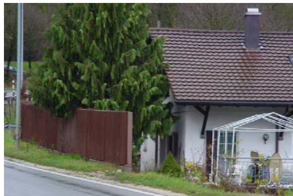
Abb. 20.52 Lavabetonwand (Wohnhaus Nähe Brugg AG)
