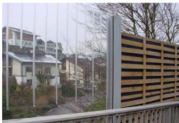
Abb. 20.71 dito, transparenter Teil im Bereich einer Brücke
