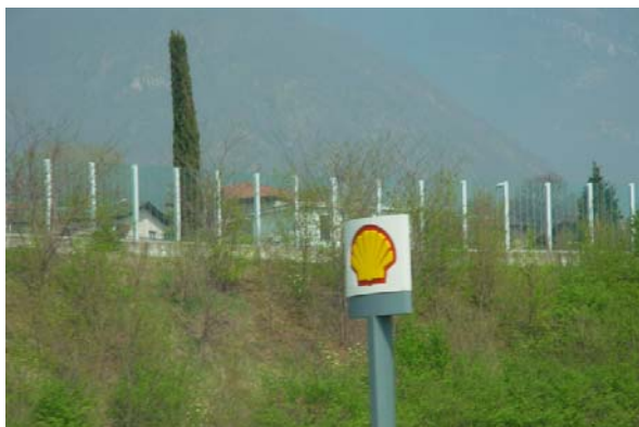
Abb. 20.33 Lärmschutzwand aus Glas (reflektierend), Nationalstrasse A2, Bellinzona TI
