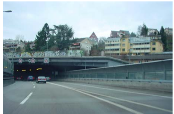
Abb. 20.46 dito, ungenügende Abschirmung des Direktschalls und vorhandene Reflexionen
