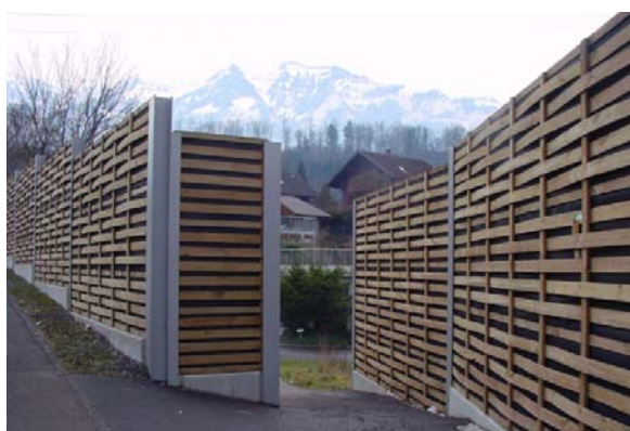
Abb. 20.70 Holz-Lärmschutzwand, Sarnen OW (Schleusenausbildung bei einem Weg)
