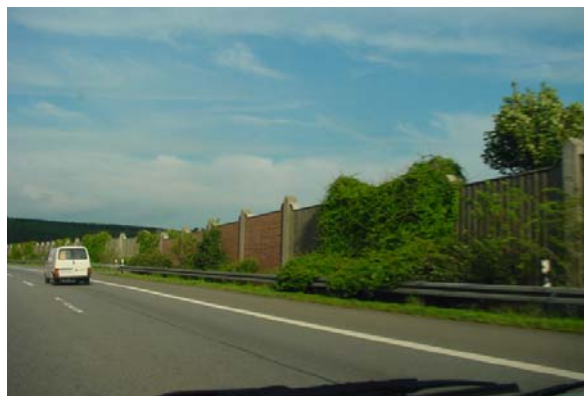
Abb. 20.29 Stark gegliederte Lärmschutzwand, Deutschland
