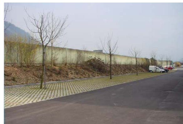
Abb. 20.24 Eine Lärmschutzwand hat auch eine Rückseite, die ansprechend gestaltet werden sollte ...
