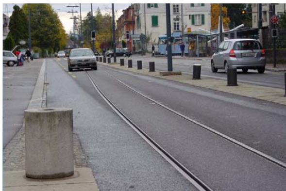
Abb. 20.10 Strassenumgestaltung (Fahrbahnverschmälerung, breitere Troittoirs, Wabern BE)
