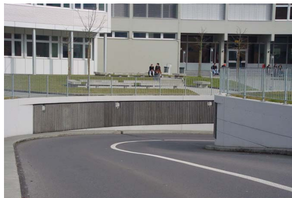
Abb. 20.21 Schallabsorbierend verkleidete Einstellhallenzufahrt, Dorfparking, Stans
