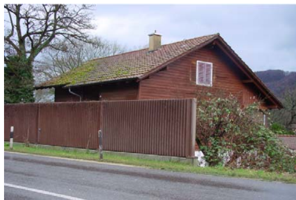
Abb. 20.53 Lavabetonwand (Wohnhaus Nähe Brugg AG)
