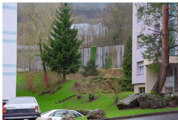
Abb. 20.55 Holzlärmschutzwand, A4 Goldau SZ
