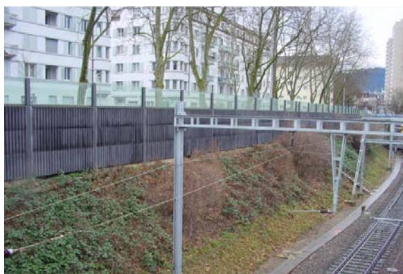
Abb. 20.62 Lavabetonwand mit aufgesetzter Glaswand, SBB-Linien Zürich-Thalwil, Stadt Zürich
