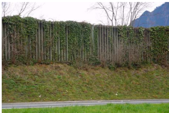
Abb. 20.49 Damm und aufgesetzter Lärmschutzwand aus Lava-Beton A2 Anschluss Stans Nord NW
