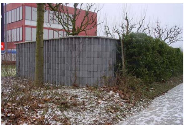
Abb. 20.68 Lärmschutzwand Fachhochschule HTA, Luzern / Horw
