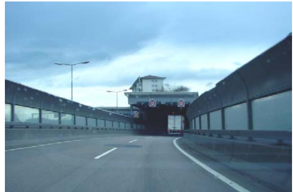
Abb. 20.45 Lärmschutzwand Glas / absorbierende ALU-Abkrümmung, A2 Sentibrücken, Stadt Luzern
