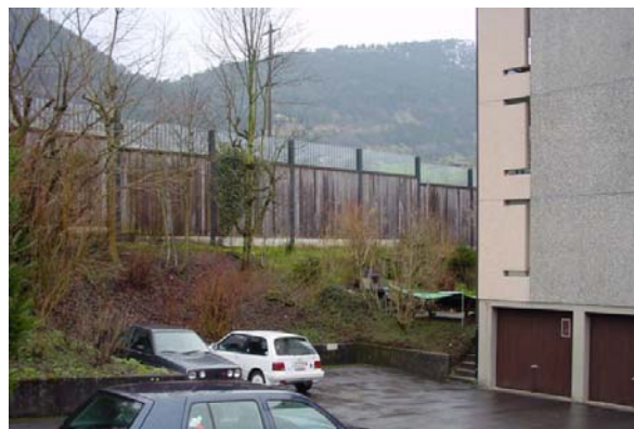
Abb. 20.54 Holzlärmschutzwand mit Glasaufsatz, A4 Goldau SZ
