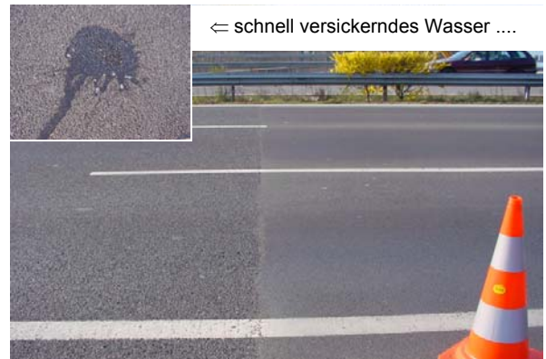
Abb. 20.13 Übergang Drainasphalt- / Splittmastix-Belag, Nationalstrasse A1, Lausanne VD
