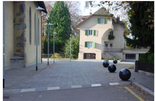
Abb. 20.5 Platzgestaltung Wesemlin, Stadt Luzern; 30er Zone, Poller, Strassenverengung, Aufpflasterung
