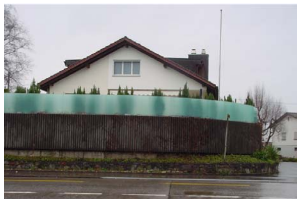
Abb. 20.50 Lavabetonwand mit farbiger Glasscheibe (Wohnhaus Freienbach SZ)
