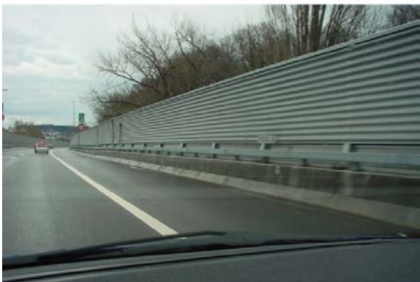
Abb. 20.60 Lärmschutzwand A3 Zürich (absorbierende Wand mit Sinus-Blech-Verkleidung)
