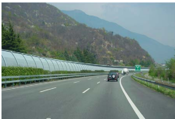
Abb. 20.31 dito, gekrümmte Mittelwand (Aussenseite reflektierend)
