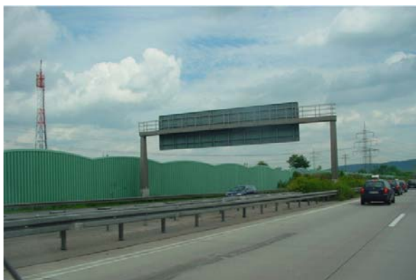
Abb. 20.28 Lärmschutzwand aus Alukassetten mit fraglicher Gestaltung, Deutschland
