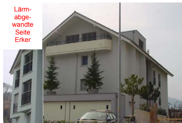
Abb. 21.29 Wohnhaus Stansstad NW (Balkonbrüstung mit Glasaufsatz, Erkerkonstruktionen)
